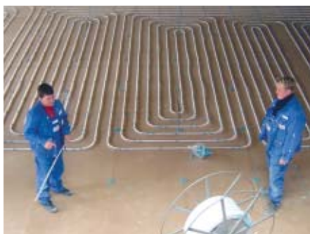
Fußbodenheizungen sind ideal für Fliesen- und Steinfußböden.
